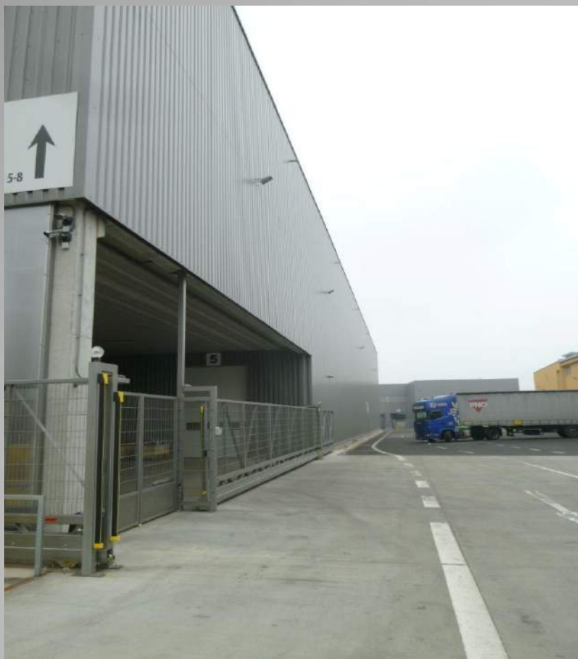
Obrázok č. 5: Exteriér skladových priestorov Haly „A“ a „B“
